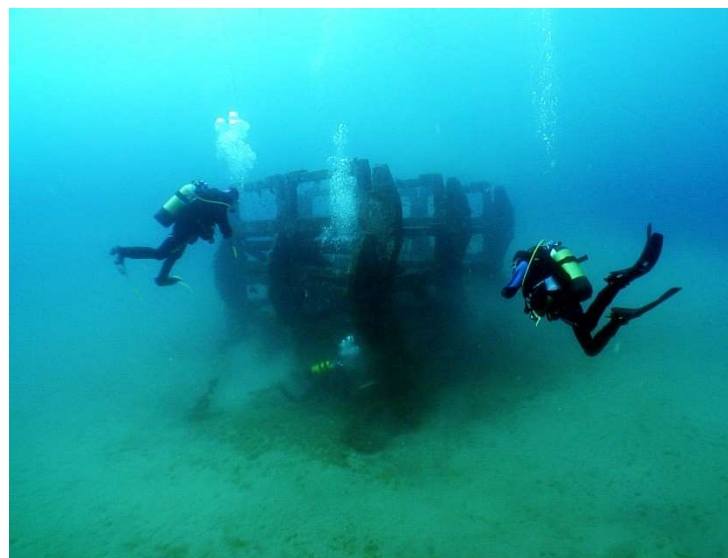
Fig. 12. Un modulo in cemento armato della Barriera per il ripopolamento ittico di Spotorno (foto archivio Nereo Sub di Spotorno).
